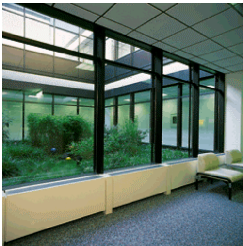
Bild 4: Innerhalb einer Brüstungsverkleidung kann gleichzeitig mit den Konvektoren auch die Frischluftzufuhr auf elegante Art gelöst werden.
