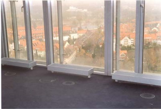
Bild 5: Die nachträglich aufsteckbare und austauschbare Konvektorabdeckung bietet serienmäßig Farbspielräume.
